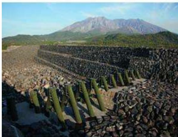
Un barrage de tube d'acier fait office de tamis. Lorsqu'un lahar dévale la pente du volcan, ce barrage permet de retenir les blocs et les troncs d'arbres charriés par ces coulées de boue.
